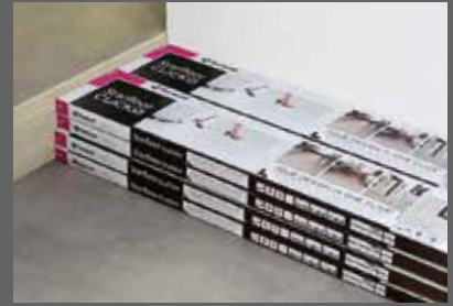
Lagra paketen plant i rummet före läggning
